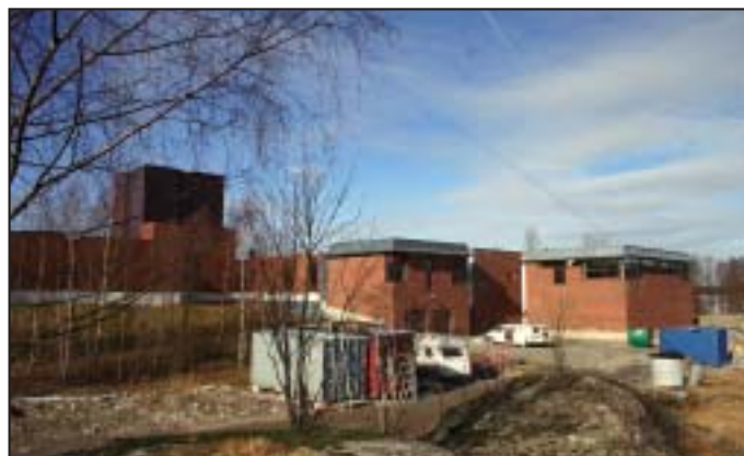
Utbygging Vansjø Vannverk.
