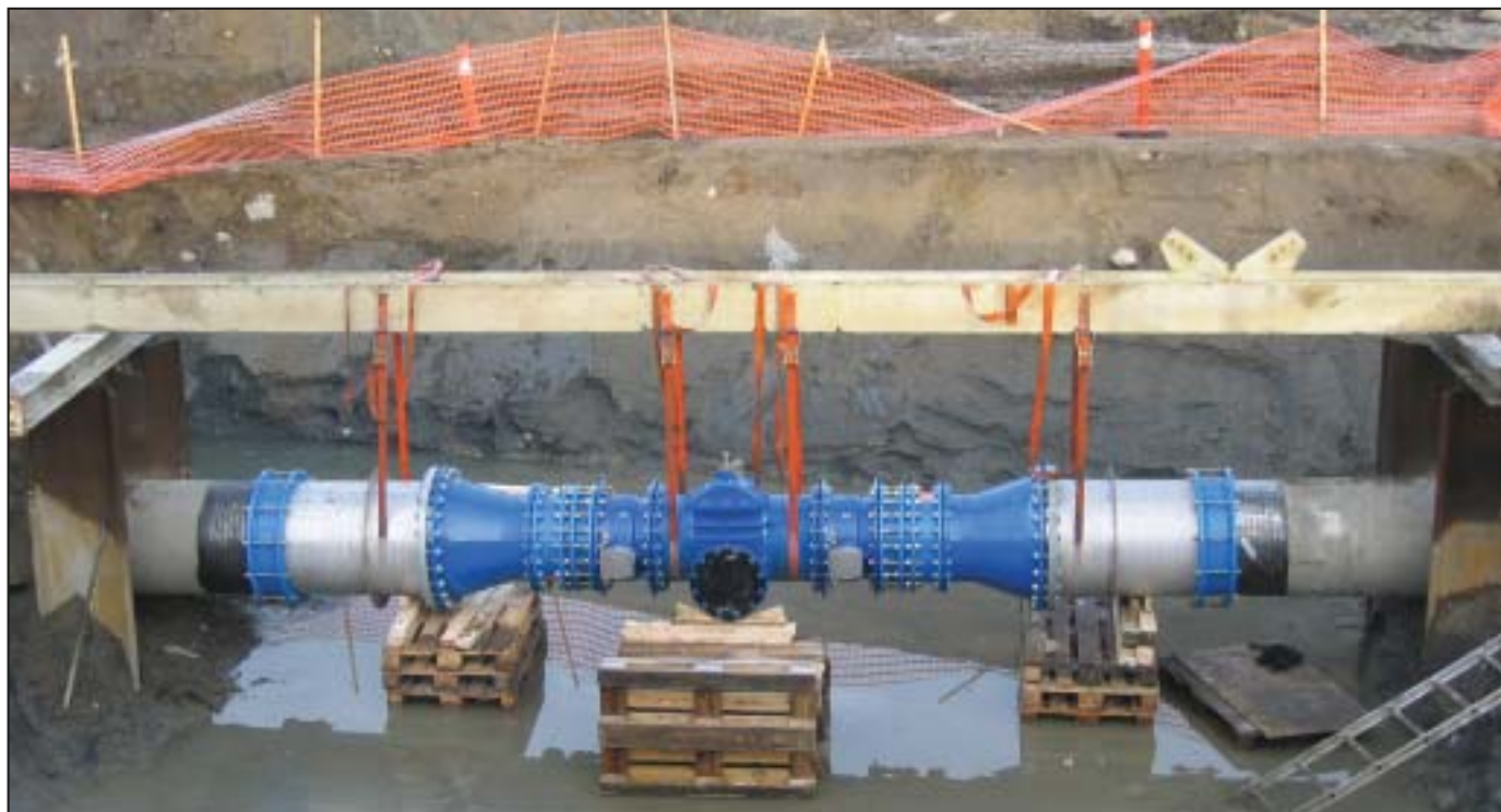
Innkapp og montering av kryss på hovedvannledningen for tilknytning av reservevannforsyningen.
