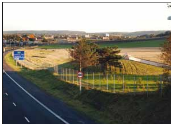
Trykkøkningsstasjonen på Grålum til høyre i bildet. Den er fylt over med jord slik at fasaden mot E6 fremstår som en gravhaug
