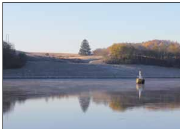
Støttefyllingen på Vestensiden av Glomma
