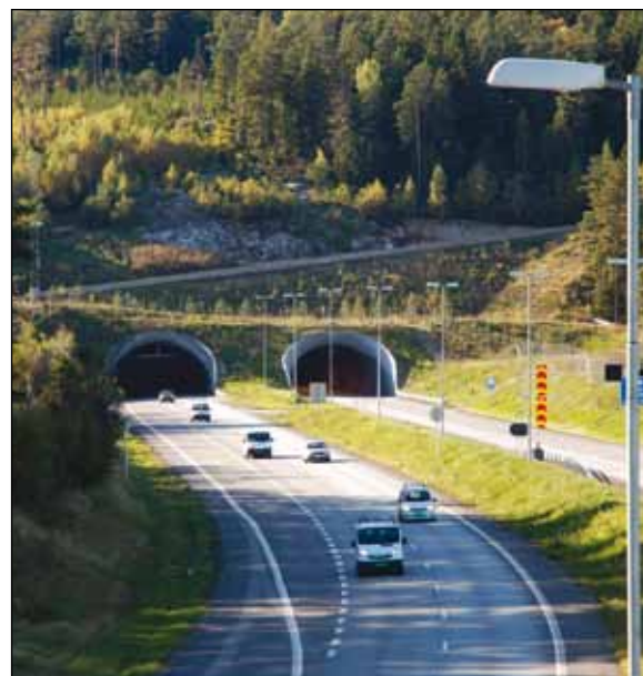
Eidettunnelen: Vannledning ligger i høyre (østre) løp
