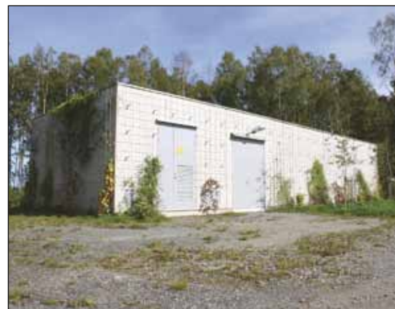
Trykkøkningsstasjonen på Rygge flystasjon
