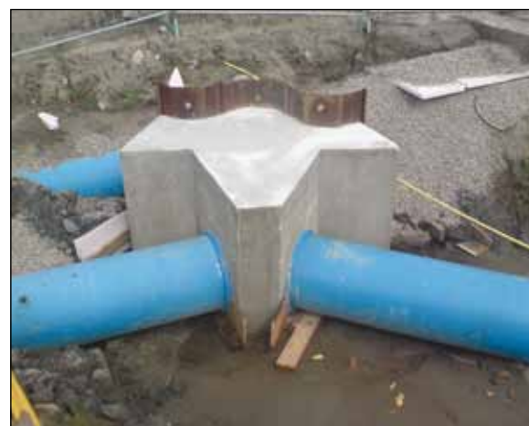
Forankring av retningsending på vannledning
