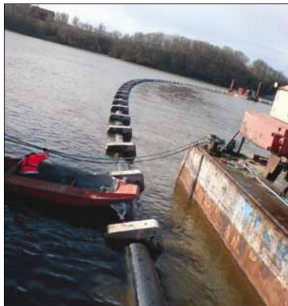
Kryssing av Glomma med vannledningen
