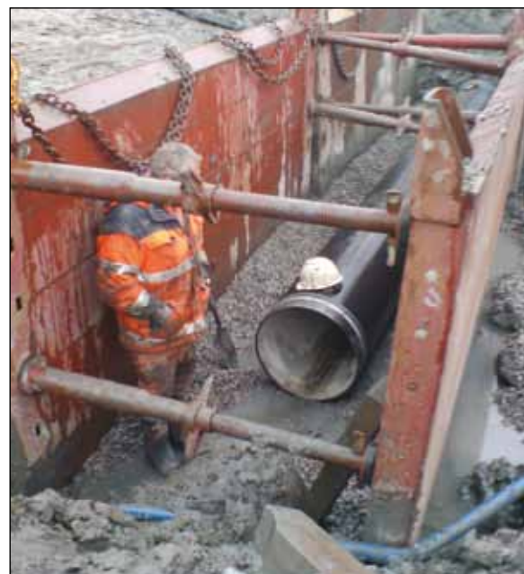
Arbeid i grøft sikret med grøftekasse
