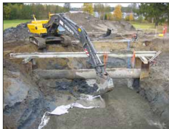
Klargjøring for tilkobling til eksisterende MOVAR-ledning på Huggenes
