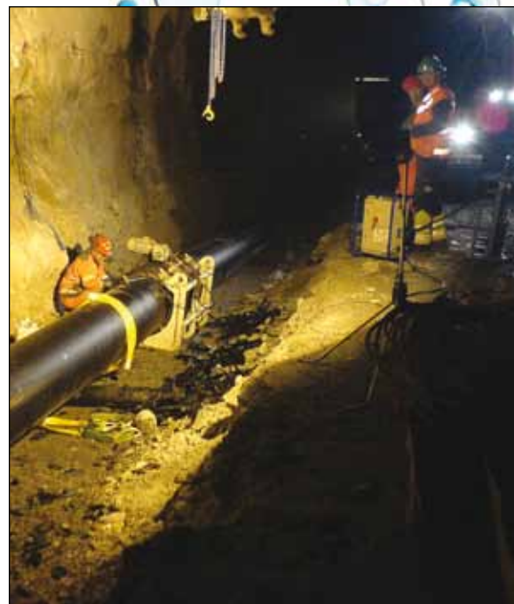
Montering av vannledning i Eidettunnelen
